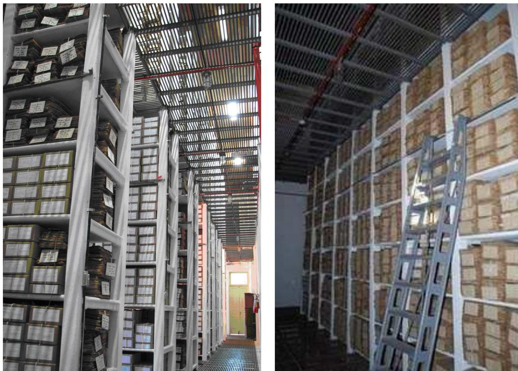
Figura 21 e 22 – Foto da interna do Arquivo Público do Estado do Rio Grande do Sul–Galerias, Estantes de concreto, Pisos vazados em estrutura em ferro, 1910. Porto Alegre: Fonte APERS.
