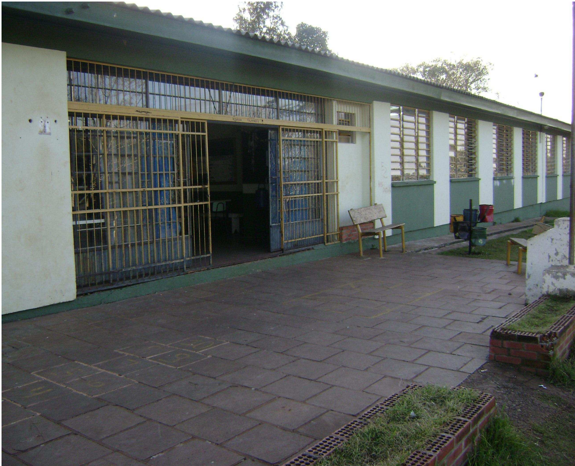
Foto 11. Vista parcial da escola municipal.
