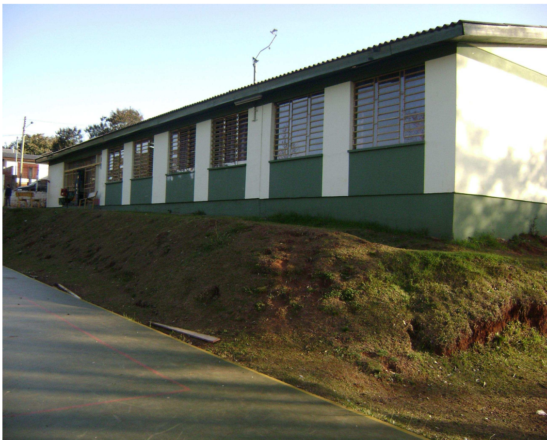
Foto 10. Vista parcial da escola municipal.
