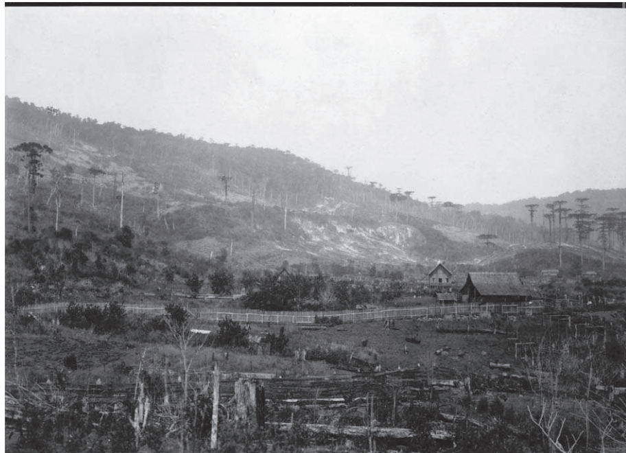
Fonte: Arquivo Histórico Municipal Juarez Illa Font - Erechim. Figura 15 – Distrito do Rio Toldo, colônia Erechim - 1922.
