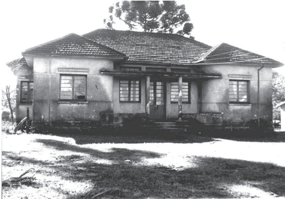
Fonte: Arquivo Histórico Municipal Juarez Illa Font - Erechim. Figura 13 – Escritório da ICA em Quatro Irmãos, em torno de 1930.
