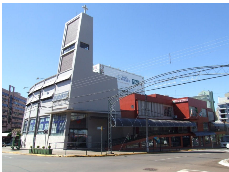
Figura 1 - Prédio atual do IABRB de Erechim em 2013. Fonte: Imagem retirada de arquivos da própria instituição.
