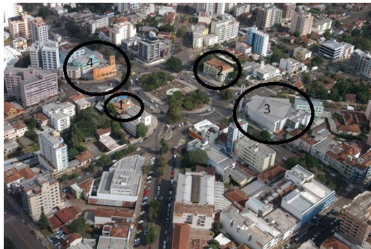
Figura 5 - Vista aérea do centro de Erechim – 1- Castelinho, antiga sede da Comissão de Terras; 2- Prefeitura Municipal; 3- Catedral Católica São José; 4- Igreja Episcopal Anglicana do Brasil e Instituto Anglicano Barão do Rio Branco. Fonte: Clic Erechim. Disponível em < http://www.clicerechim.com.br >.
