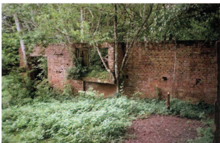
Figura 11 - Usina Sociedade Força e Luz Constantina Ltda – Ruínas da casa de força
