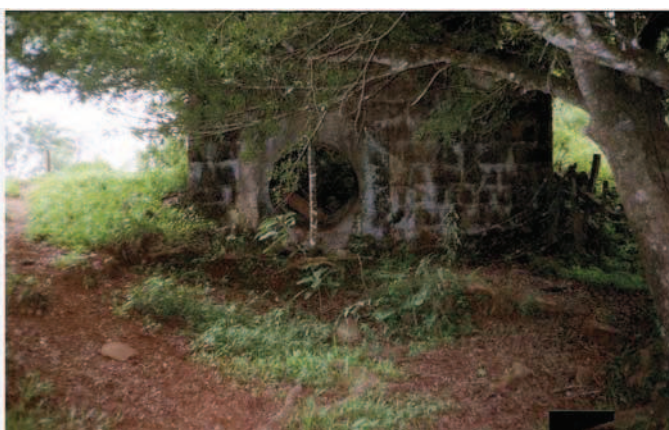
Figura 8 - Usina Sociedade Força e Luz Constantina Ltda – Saída do reservatório
