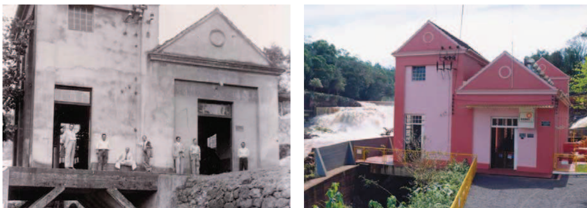
Figura 5 - Usina da Sede, a mais antiga usina ainda em operação no Rio Grande do Sul, em Ijuí/RS Fonte: Departamento Municipal de Energia de Ijuí (DEMEI).
