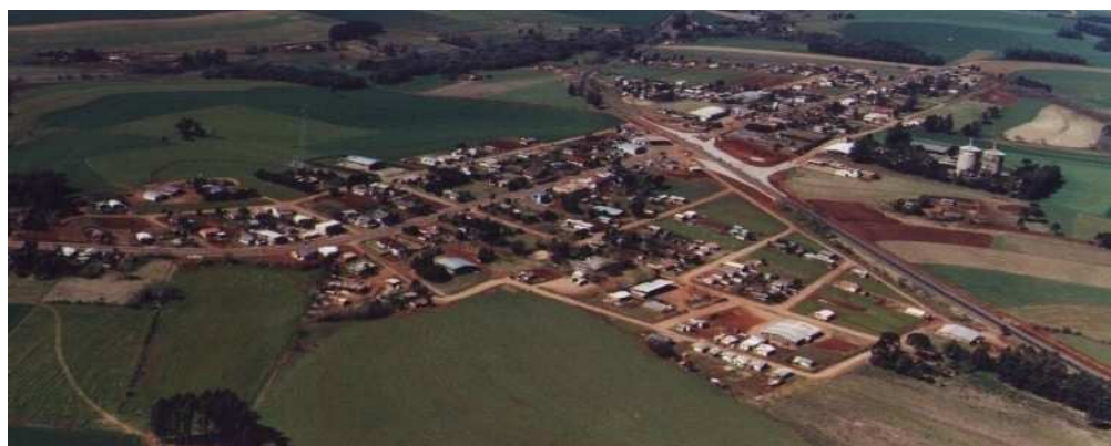
Foto 01 – Foto aérea da sede município Fonte: Arquivo da SMEC
