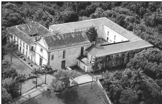
Figura 7: Seminário de Olinda (PE), atualmente.
