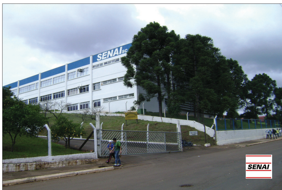
Foto 7 - Faculdade de Tecnologia Senai Chapecó, Chapecó. Fonte: Faculdade de Tecnologia Senai Chapecó, 2008.
