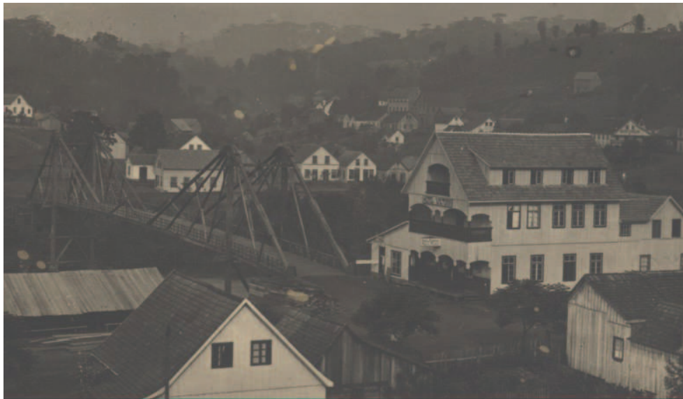
Figura 7: Foto da Ponte sobre o Rio do Peixe: 1934
