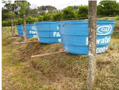
Figura 9 - Aspecto dos reservatórios utilizados para depósito do dejetos líquido de suíno junto à área experimental. Epagri-Cepaf, Chapecó, SC.
