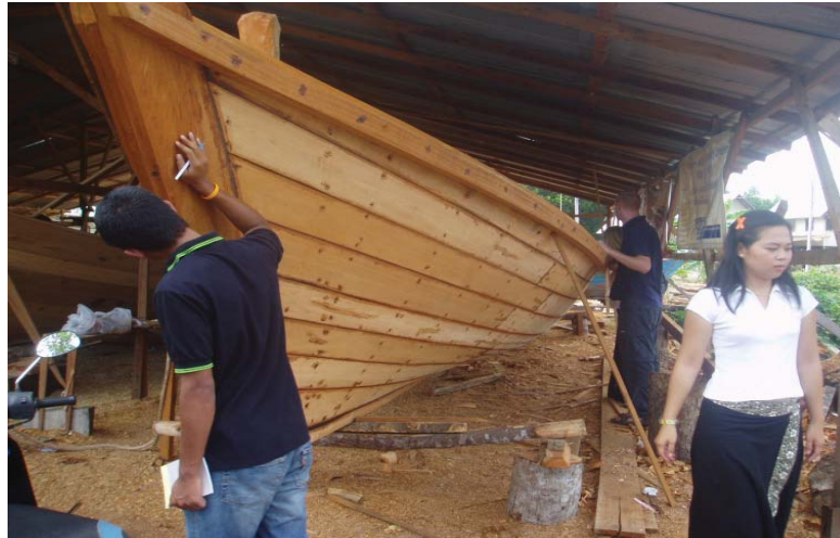
Figura 2.13 - Construção de barcos no conceito stick building (Fonte: http://informationincontext.typepad.com/.a/6a01156f1433ae970c0115706ca365970b-pi )
