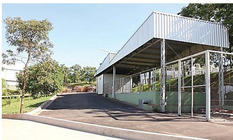
Figura 15 - Estação de tratamento de efluentes.
