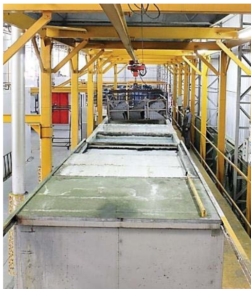
Figura 11 - Processo de tratamento superficial.
