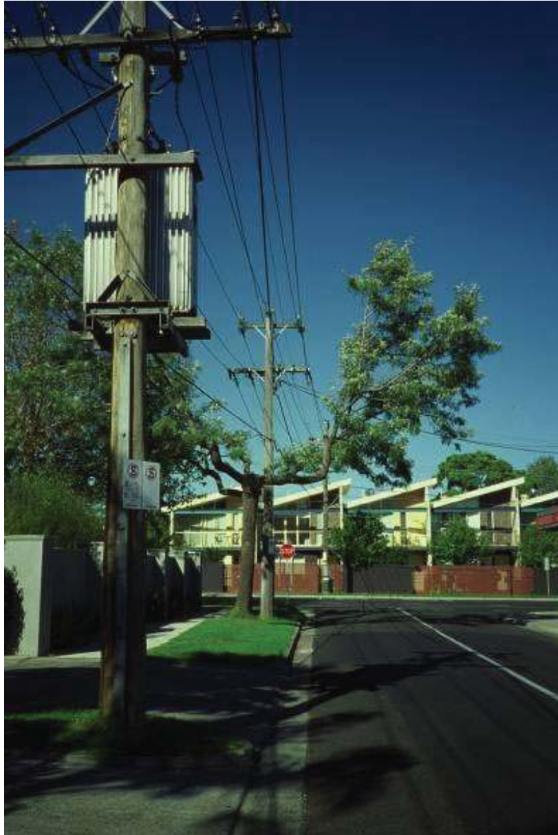
Figura 10: Árvore descaracterizada para dar passagem às linhas de energia elétrica. Fonte: Helliwell (2008).
