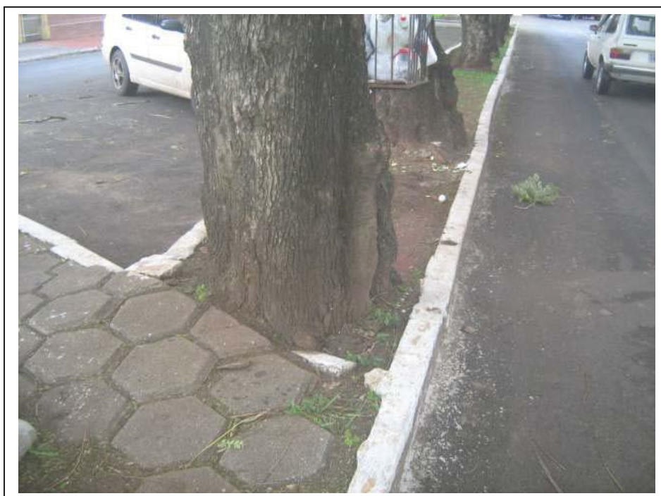
Figura 29: Vista da gola do canteiro central da rua General Câmara.
