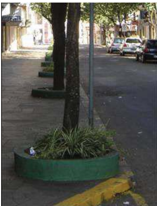
Figura 53 - Canteiros executados posteriormente as árvores
