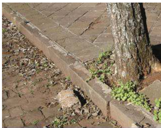
Figura 65 - Vista da Quadra 01, passeio oeste, sarjeta de paralelepípedo
