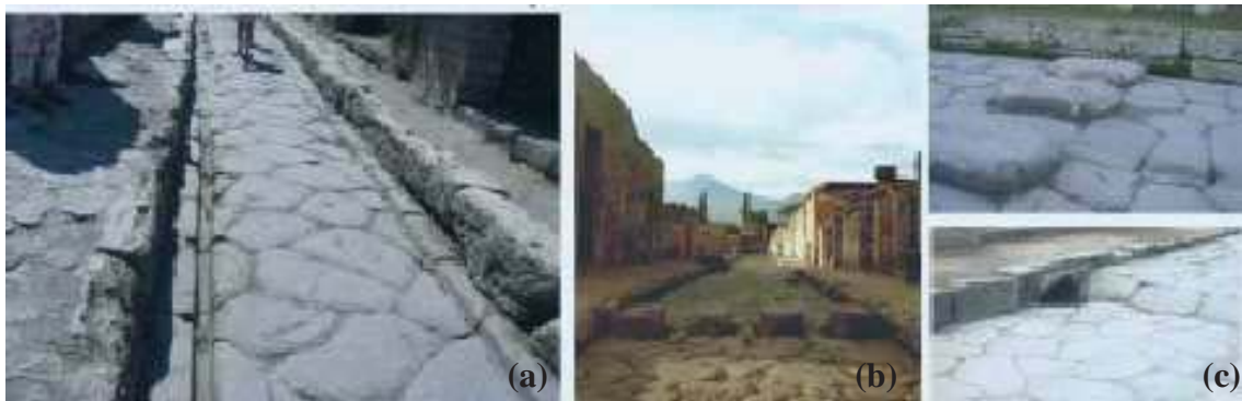
Figura 3 - Ruas de Pompéia, Itália: a) Rua com sulco secular de carroças; b) Travessia a seco c) Bueiro para esgoto.
