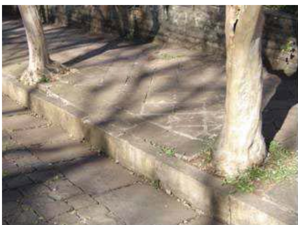
Figura 64 - Vista da Quadra 02, passeio oeste, sarjetão de pedra basalto
