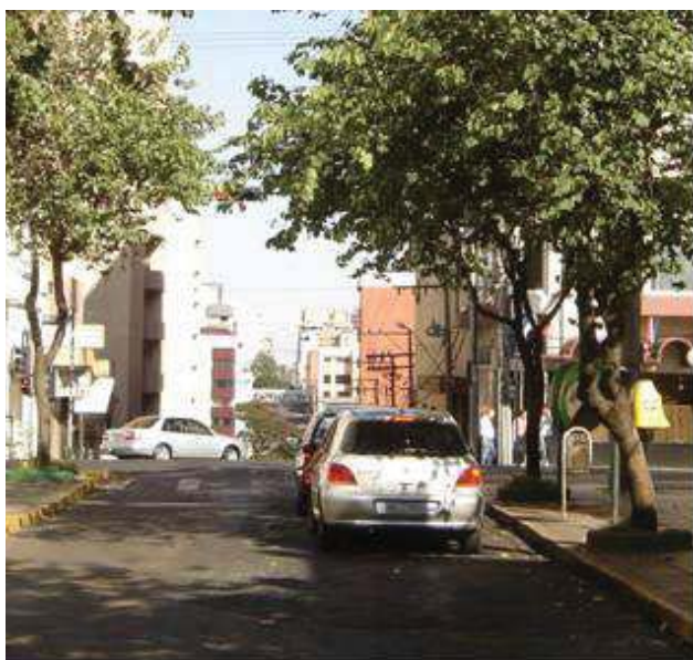
Figura 50 - Vista da Quadra 03, esquina com a rua Coronel Chicuta, o semáforo está parcialmente encoberto pela folhagem da árvore
