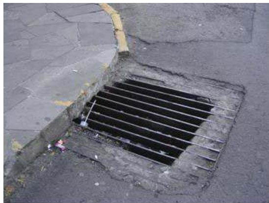
Figura 46 - Boca-de-lobo na Quadra 02, esquina com a Rua Bento Gonçalves
