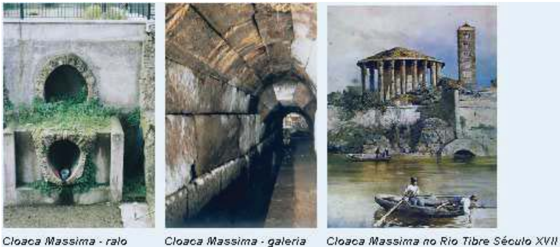
Figura 2 - Rede de esgoto em Roma
