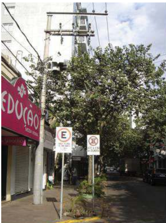
Figura 42 - Detalhe do posteamento
