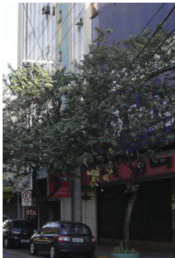
Figura 49 - Vista do início da Quadra 02, arborização está muito próxima à rede de alta tensão
