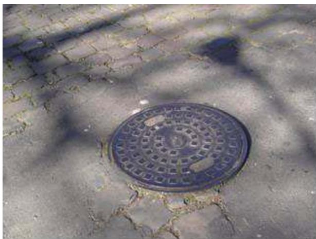
Figura 63 - Tampa metálica do poço de visita da rede de esgoto
