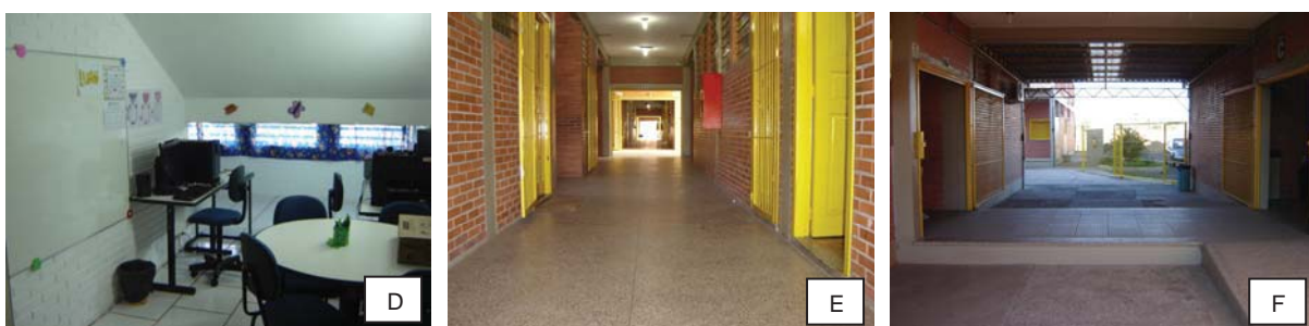
Figuras 88, 89 e 90 - Sala de recursos multifuncional, circulação e degrau no pátio externo
