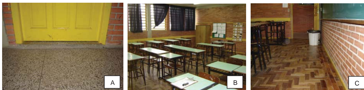
Figuras 102, 103 e 104 - Degrau junto à porta e carteiras e quadro-negro das salas inacessíveis à PCR.
