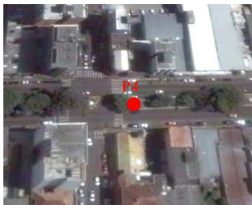
Figura 11: Vista superior do ponto 4
