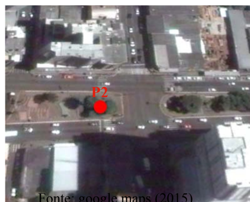
Figura 9: Vista superior do ponto 2
