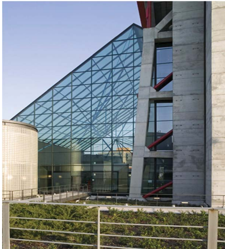
Figura 5: Vista externa da Torre de átrio Hesperia
