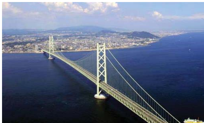
Figura 4: Ponte Akashi-Kaikyo (Japão)
