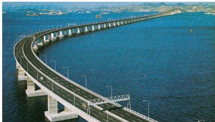
Figura 6: Ponte Rio-Niterói (Brasil)
