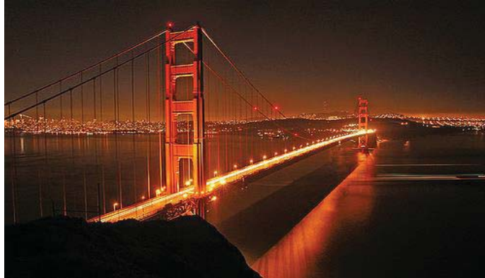
Figura 2: Ponte Golden Gate (Estados Unidos)
