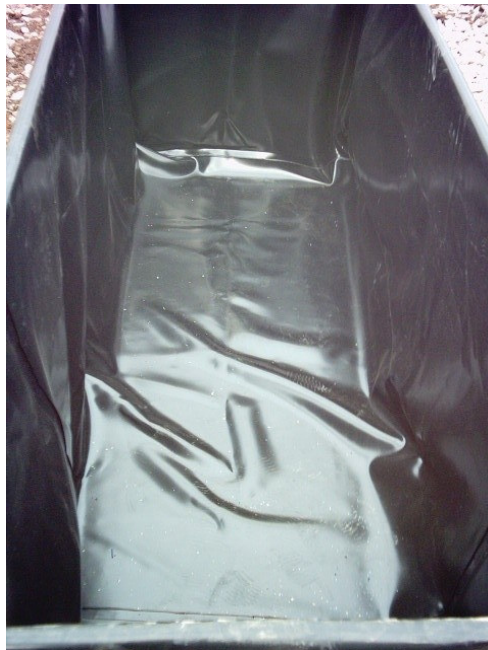
Figura 10 - Leito impermeabilizado com manta de PVC.
