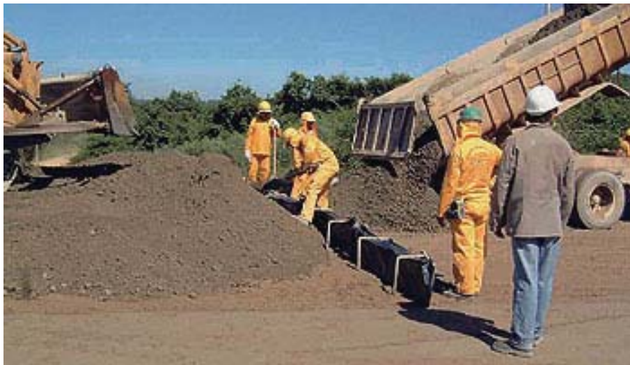
figura 7: Lançamento de CCR
