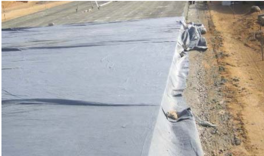
figura 14: Barreira isolante térmica
