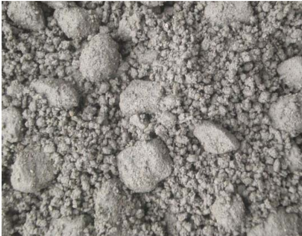
figura :11 Textura do concreto compactado a rolo
