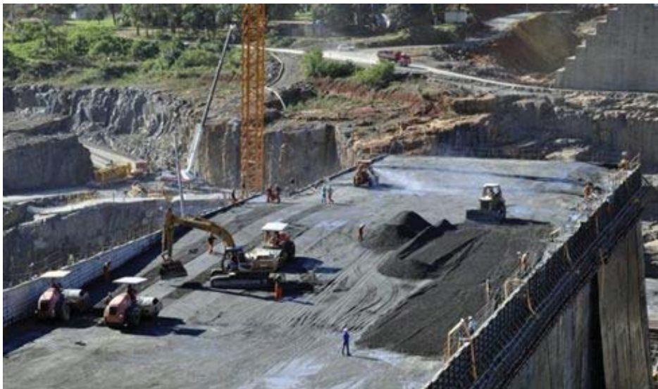
figura 1:CCR utilizado em maciço de usina hidrelétrica no Estado do Paraná
