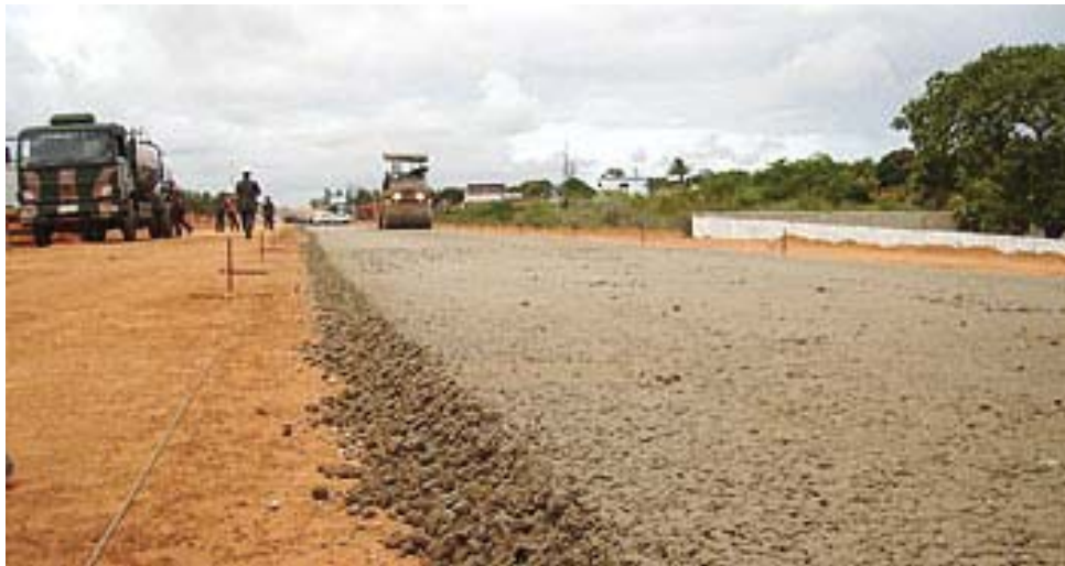
figura 8: Lançamento de CCR a ser compactado
