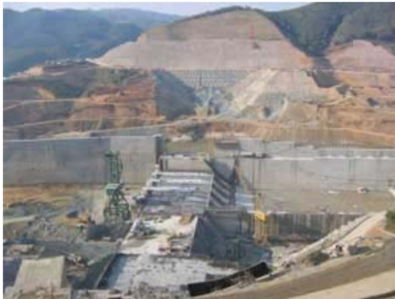
figura 4: Projeto de barragem em CCR na China
