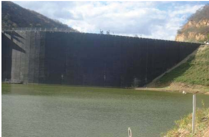
figura 6: Paramento em arco da barragem do Saco de Nova Olinda
