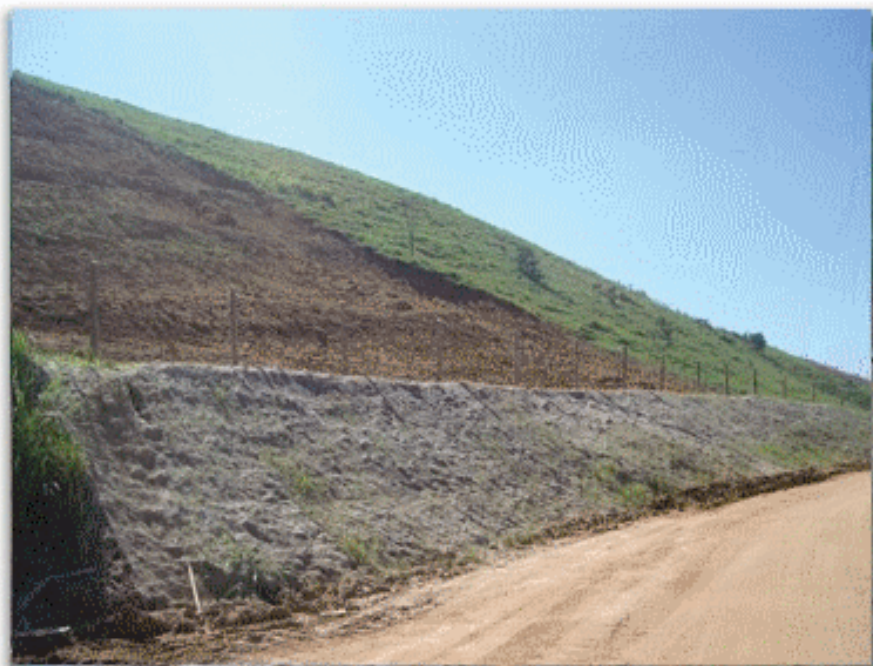
figura 18: Fibras vegetais utilizadas para reforço de taludes.
