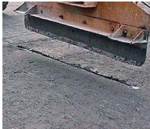
figura 10: Junta transversal de construção
