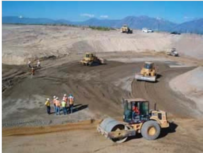
figura 3: Espalhamento e compactação de CCR
