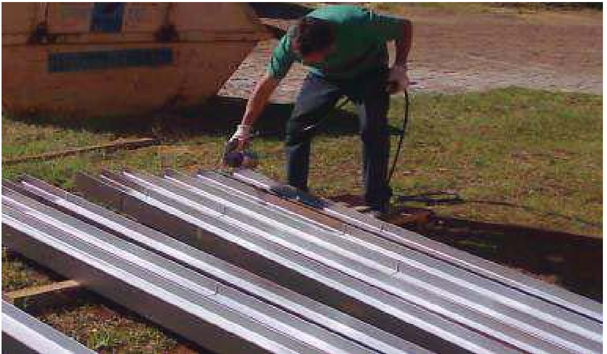
Figura 29 - Aplicação de fundo primer
