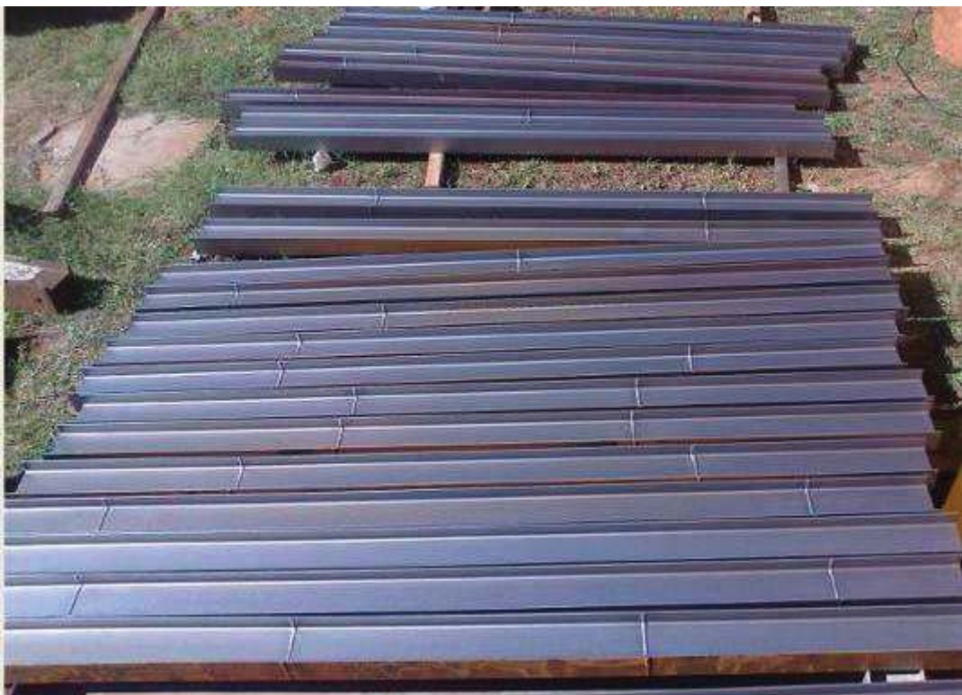
Figura 28 - Perfis emendados nas posições pré estabelecidas.
