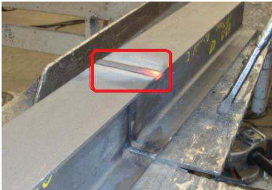
Figura 25 - Vigas sendo emendadas ainda com solda quente.
