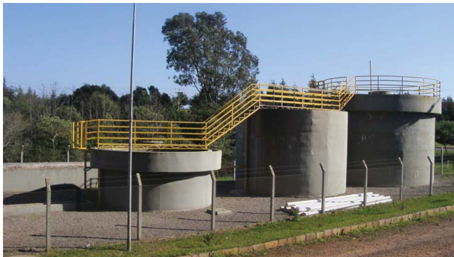
Figura 5 – Vista, da esquerda para direita, do Decantador Secundário, Tanque de Aeração e Reator Anaeróbio -UASB da ETE-UPF.
