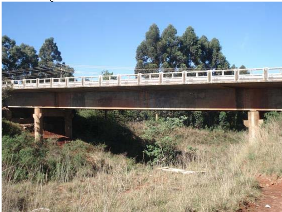
Figura 28: Viaduto V2 - Mesoestrutura e Infraestrutura
