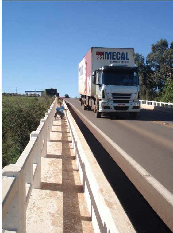
Figura 59: Fonte de vibração utilizada na amostra 1- V2
