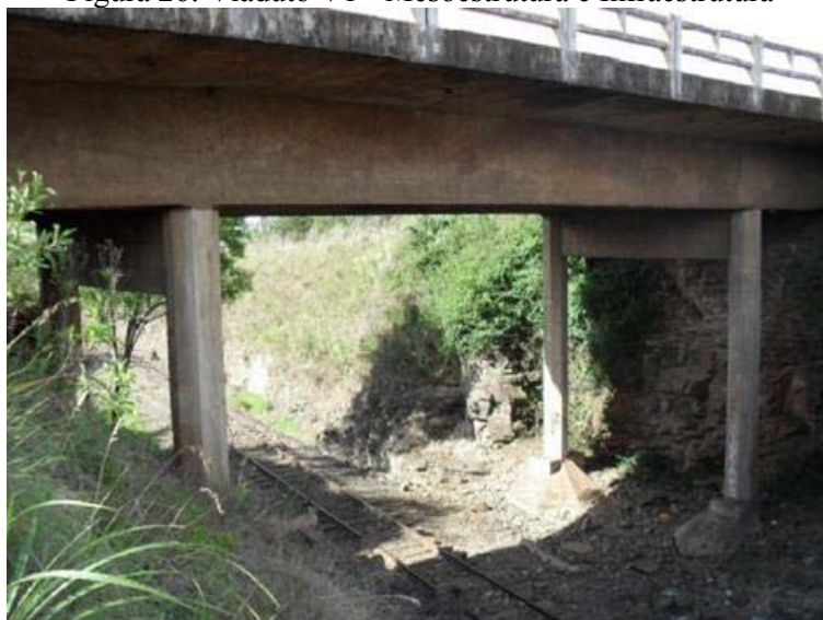
Figura 26: Viaduto V1 - Mesoestrutura e Infraestrutura
