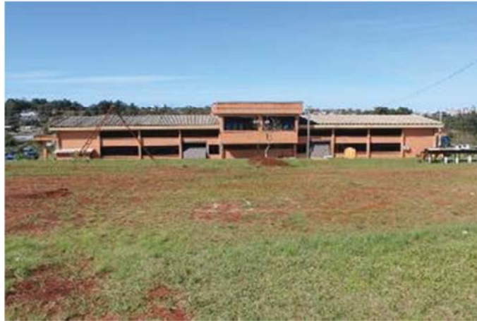
Figura 14 - Campo experimental de geotecnia.
