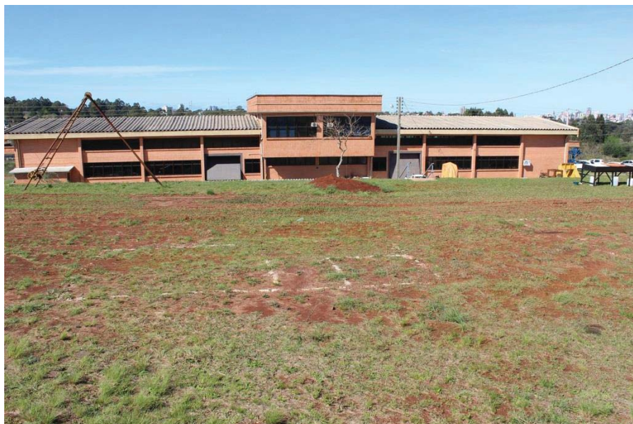
Figura 12 - Imagem do Campo Experimental de Geotecnia.
