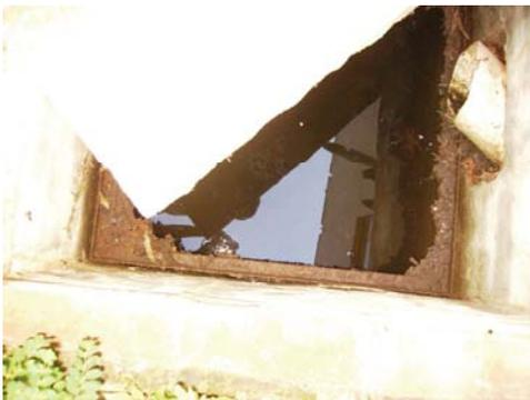
Figura 36: Caixa de retenção de sólidos - 2
