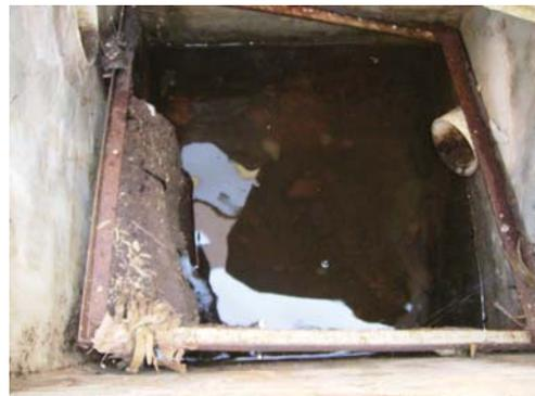
Todos os elementos que fazem parte do sistema, principalmente os reservatórios inferiores de consumo de água pluvial, como o superior de água pluvial, incluindo os reservatórios de reserva para incêndio, nunca sofreram manutenção. Os reservatórios de consumo, ainda sofrem uma troca permanente de água devido a sua demanda e a entrada de água potável para suprimento da mesma, mas os de reserva de incêndio continuam com a água parada, servindo de proliferação para agentes micro bacteriológicos.
