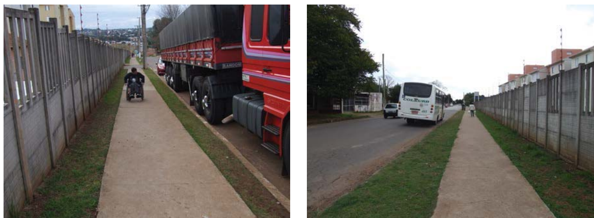
Figura 28 – Passeios públicos externos ao condomínio JBI pavimentados
