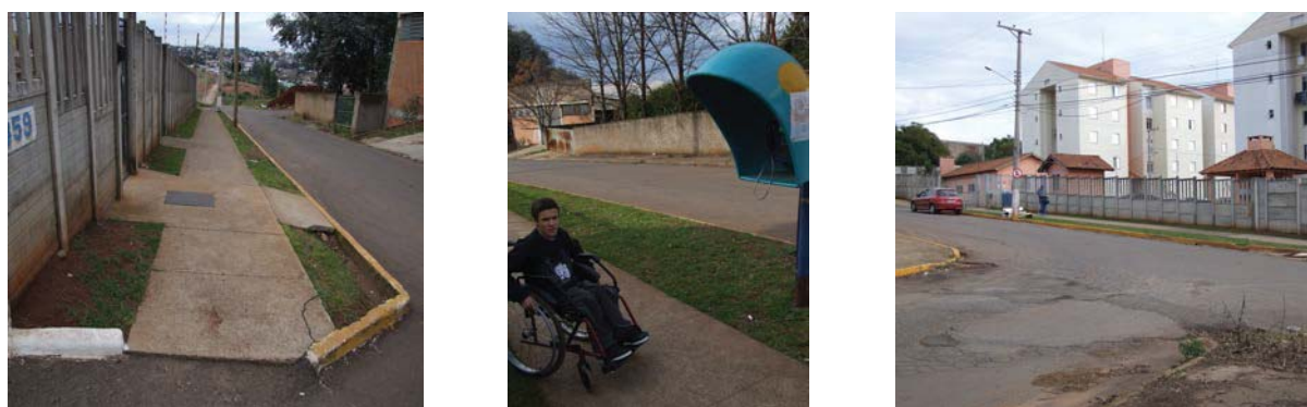
Figura 32 – Vistas do entorno do condomínio JBII: desníveis, falta de estacionamento
