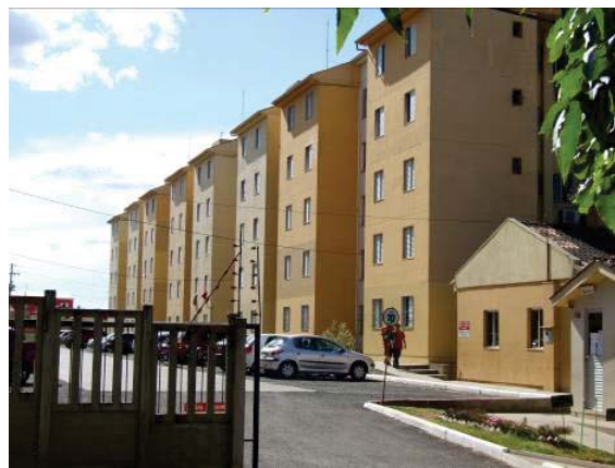
Figura 17 – Vista geral do conjunto PAR JBII
