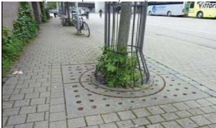
Figura 32 - Piso poroso na calçada e na gola da árvore.
