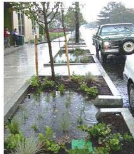
Figura 17: Canteiros pluviais (molhado).
