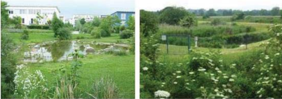
Figura 35 - (a) Lagoa pluvial – parte do sistema de drenagem do bairro de Rieselfeld; (b) Lagoa Seca (ou de infiltração).
