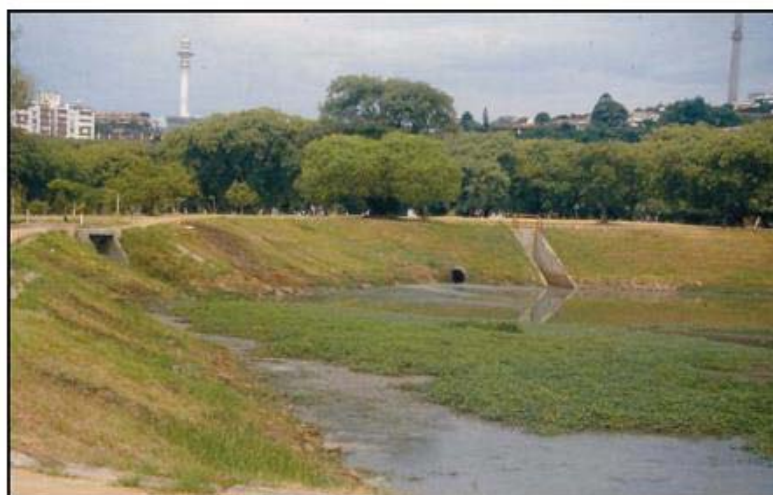
Figura 7 - Bacia de contenção, Porto Alegre, RS.
