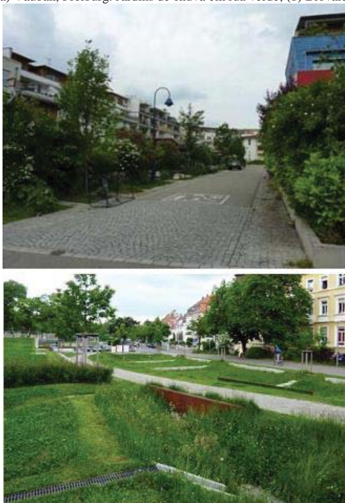
Figura 34 - (a) Vauban, Freiburg. Jardins de chuva em rua verde; (b) Biovaletas em níveis.
