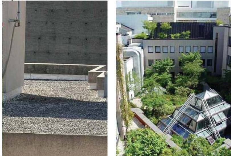
Figura 10 - (a) Telhado armazenador e (b) Telhados verdes em Düsseldorf.
