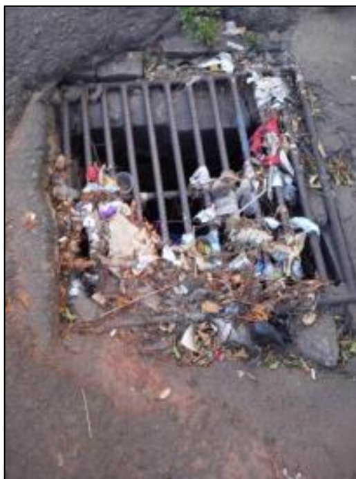
Fonte: Plano Municipal de Saneamento Básico de Passo Fundo (2013)
