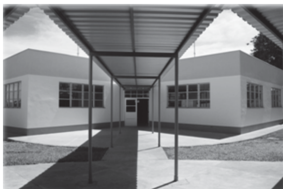
Figura 40 - Prédio dos laboratórios de informática.
