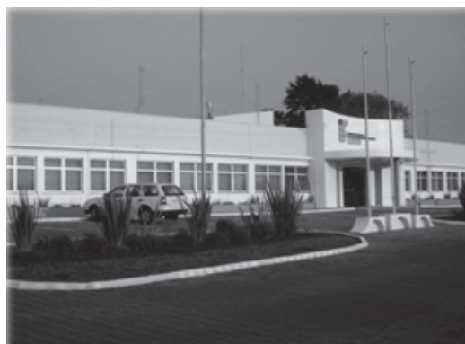
Figura 41 - Prédio do setor administrativo.
