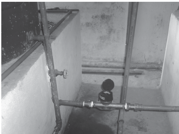
Figura 49 - Equipamentos instalados no prédio do setor administrativo.
