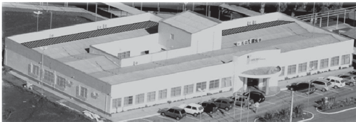
Figura 42 - Área de coleta do prédio do setor administrativo.
