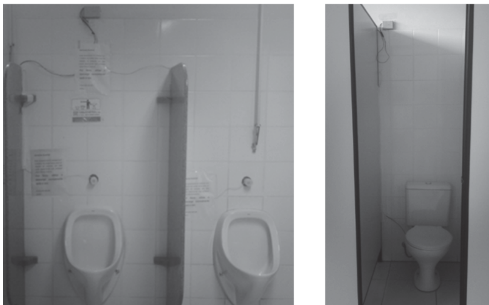
Figura 69 - Local de instalação das MTEs nos banheiros.
