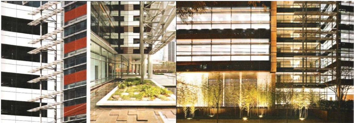
Figura 5 – Detalhe dos brises e vidros do Jatobá Green Building
