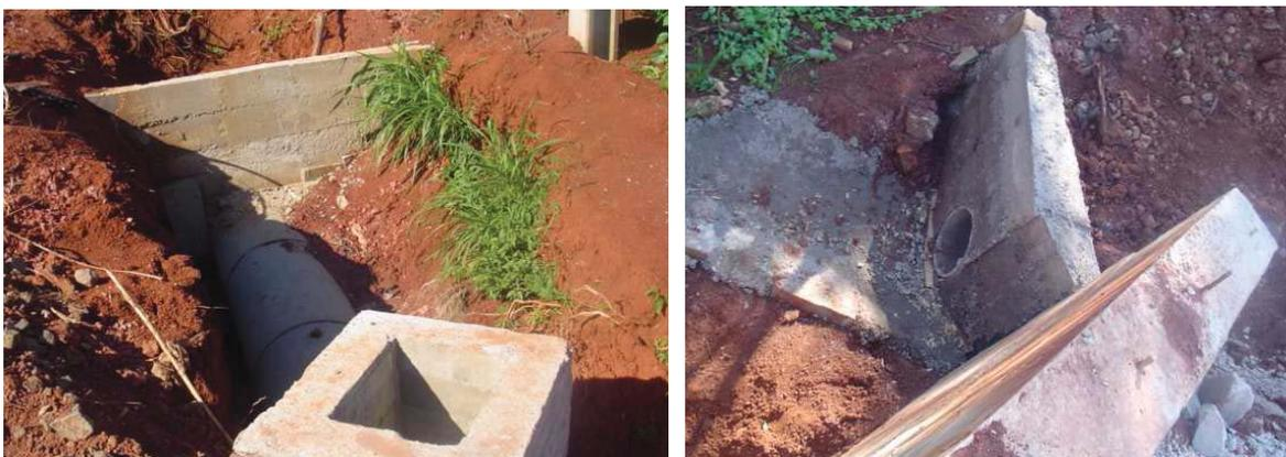
Figura 47 – Dispositivos de drenagem executados juntamente com as últimas pavimentações no ano de 2008.
