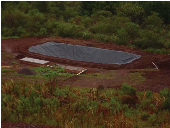
Figura 13 - Lagoa de tratamento do lixiviado, com revestimento em PEAD. São Domingos do Sul, RS, 2003.
