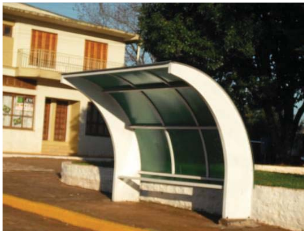
Figura 59: Parada de ônibus, avenida Julho de Castilhos
