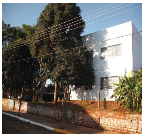
Figura 37: Escola Estadual Barão Homem de Mello, rua Recreio
