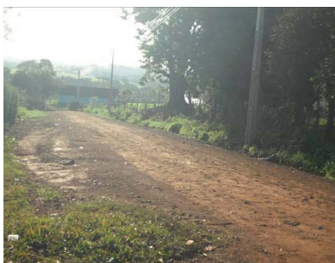
Figura 71: Rua sem pavimentação avenida Julho de Castilhos
