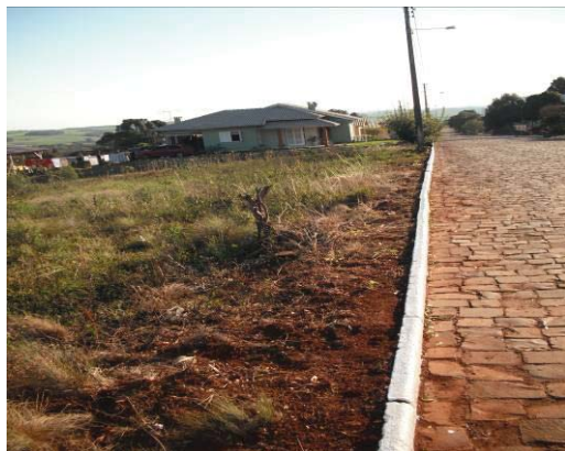
Figura 60: Passeio inexistente na rua Fermino Rosa
