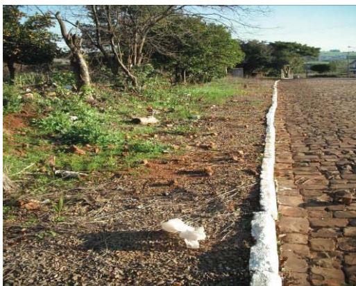
Figura 62: Passeio inexistente na rua Leonardo Sefrin
