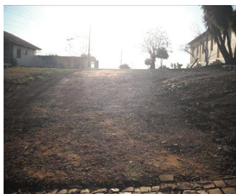
Figura 72: Rua sem pavimentação rua José Junges
