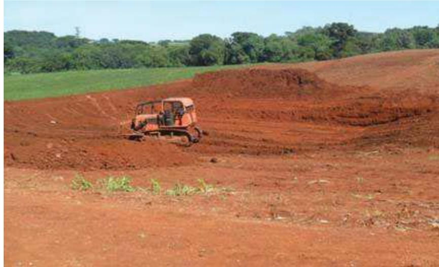
Figura 12. Construção de tanque escavado
