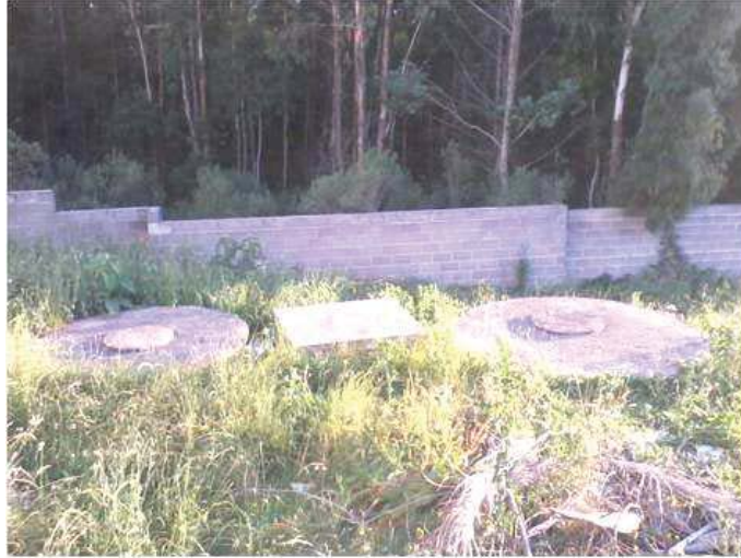
Figura 78: Tanque séptico, filtro anaeróbico e sumidouro.
