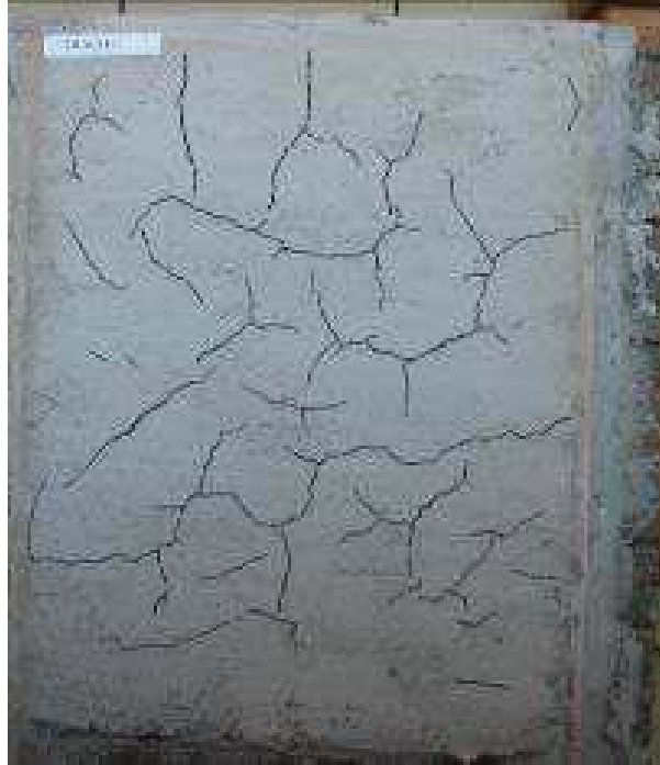
Figura 34: Painel marcado para medição das fissuras.
