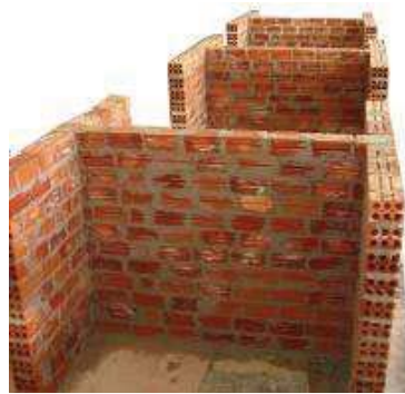
Figura 30: Execução dos módulos dos painéis.
