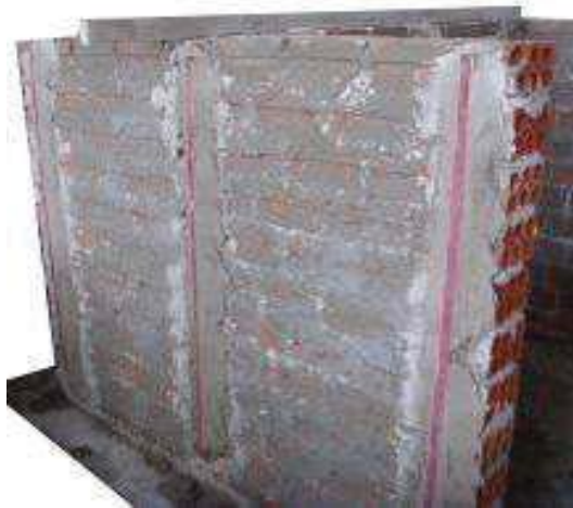
Figura 31: Execução do chapisco e mestras nos painéis.
