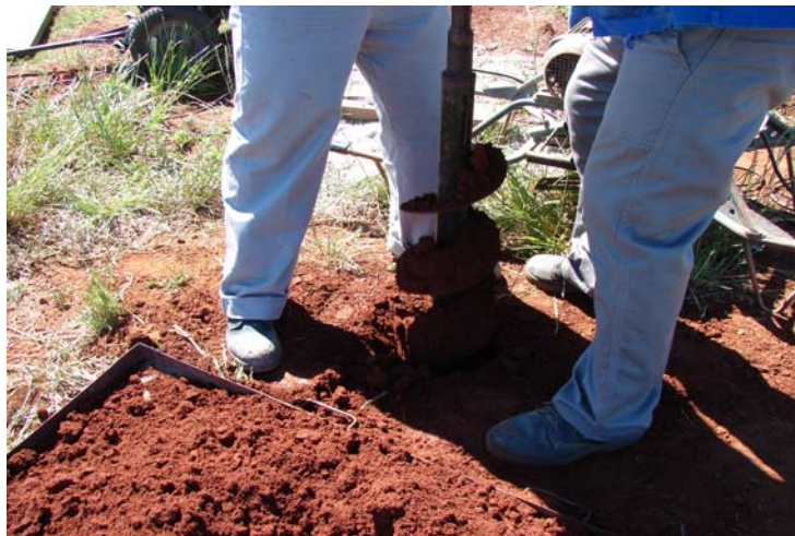
Figura 20 – Trado helicoidal utilizado para a perfuração das estacas.
