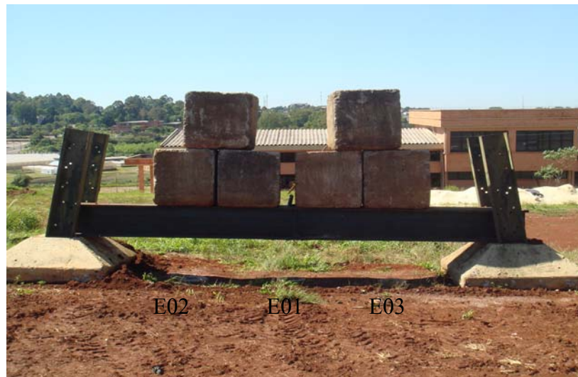
Figura 26 – Pórtico metálico e elementos de reação na forma de blocos de concreto utilizados nas provas de carga estática.
