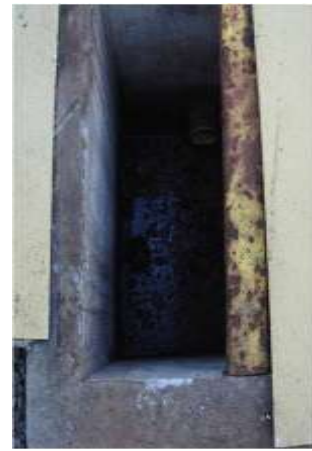
(c) Entrada da ETE
