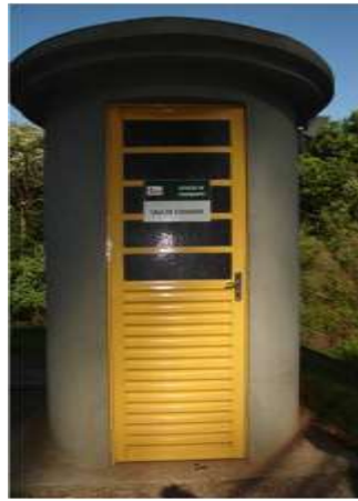
(b) Sala de comando
