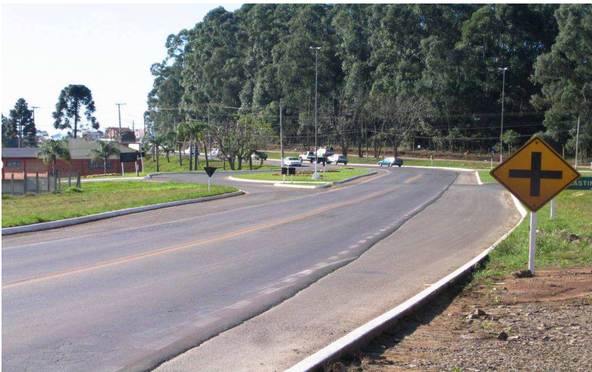
Figura 26 - Trevo Norte de acesso a cidade de Marau, em curva
