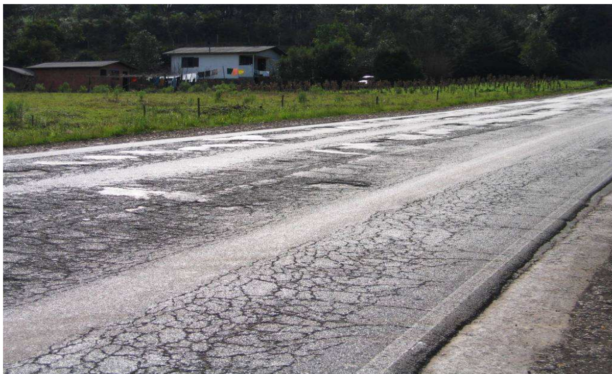
Figura 17 - Trincas Classe III, no trecho entre as cidades de Casca a Marau.
