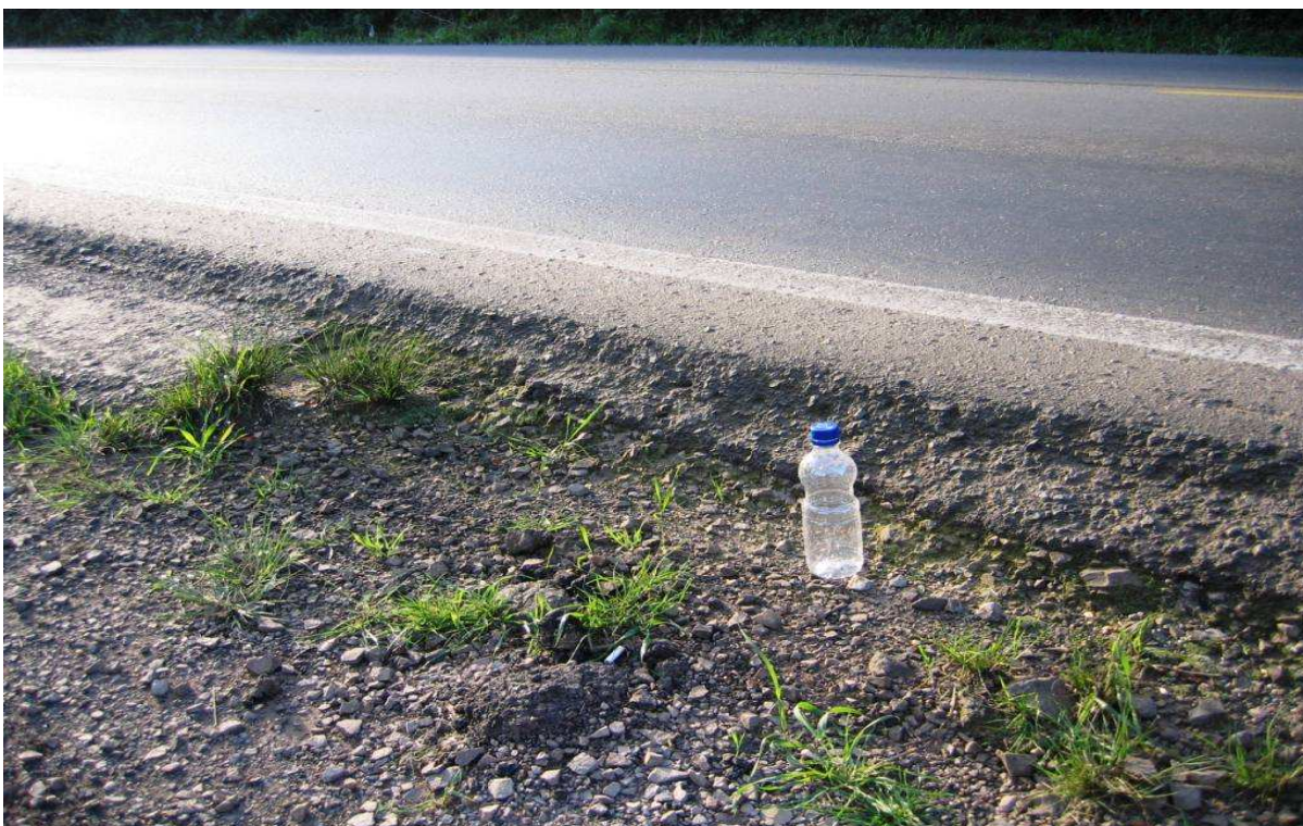
Figura 27 - Grande degrau em acostamento entre os municípios de Marau a Passo Fundo.
