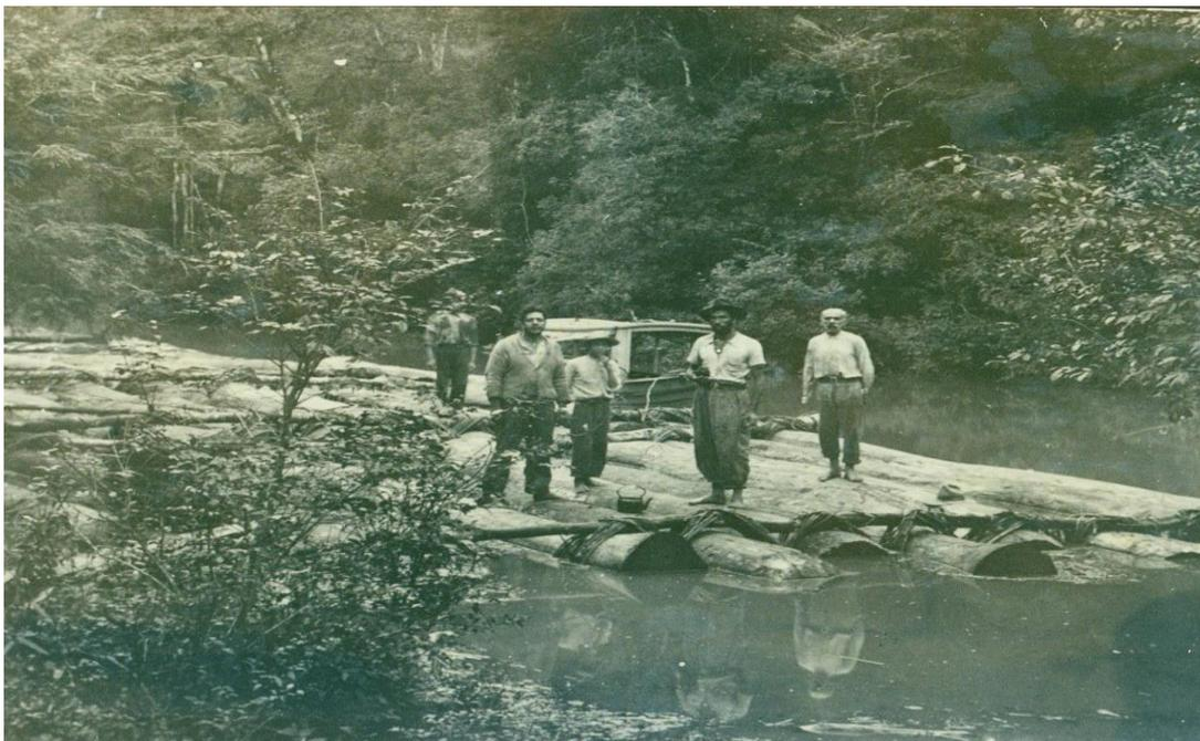
**Figura 14.** Balsa de toras de madeira. Vêm-se alguns trabalhadores: remadores, cozinheiros, balseiro prático, bons nadadores para recolher a madeira caso houvesse estouro da balsa (Dec. 1930)
