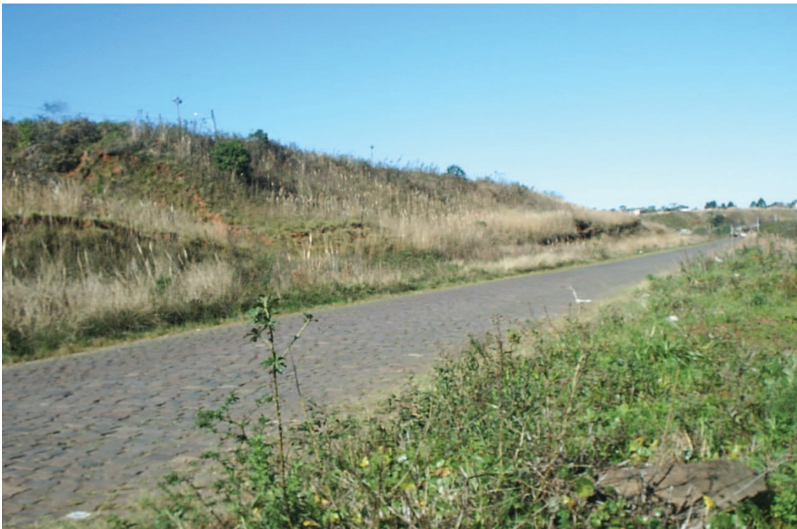
Figura 18. Obstáculo natural com o aterro da rede ferroviária
