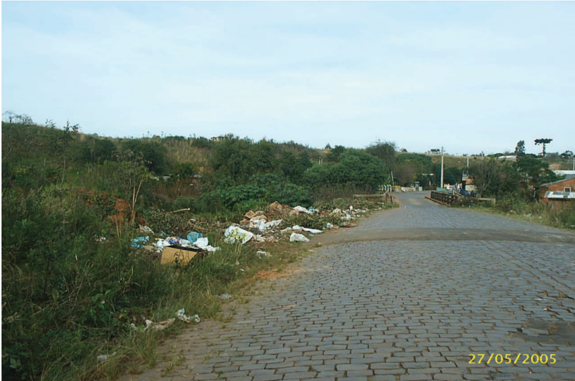
Figura 21. Estrangulamento viário da Avenida Sete de Setembro (ponte sobre o rio Passo Fundo)
