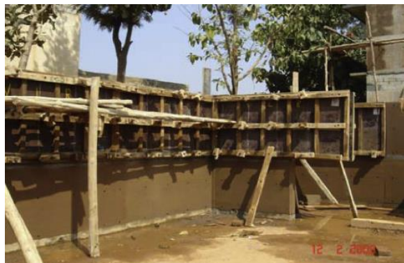
Figura 18 - Fôrmas das paredes de taipa com cimento estabilizado.
