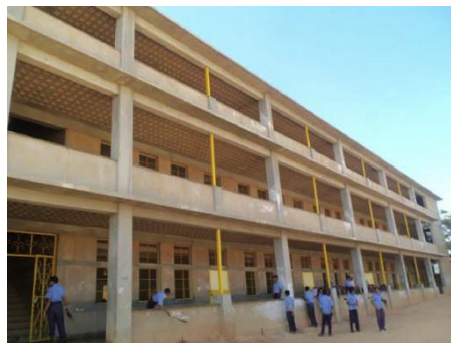
Figura 17 - Escola em construção com os métodos construtivos empregados.
