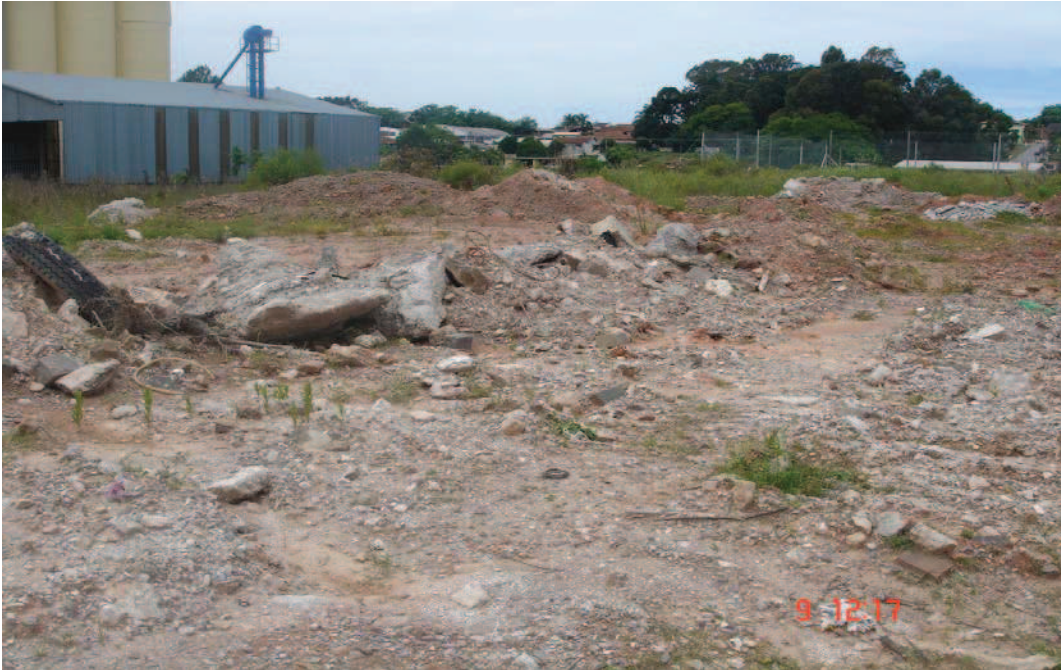
Figura 32 – Vista da área nº. 7.
