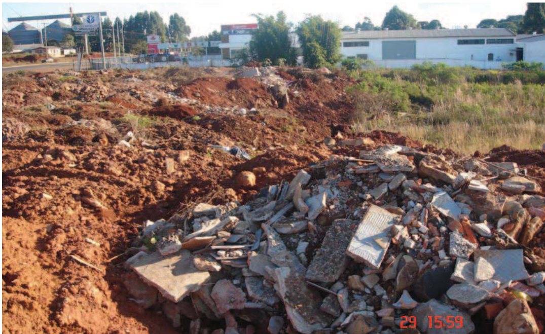
Figura 18 - Vista geral da área nº. 2.
