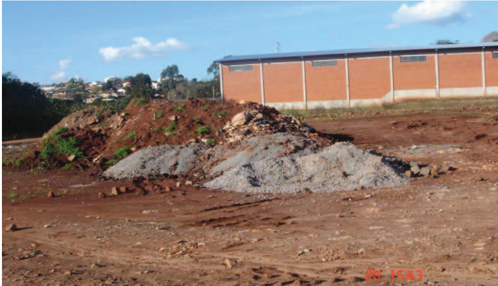
Figura 27 - Vista geral da área nº. 5.
