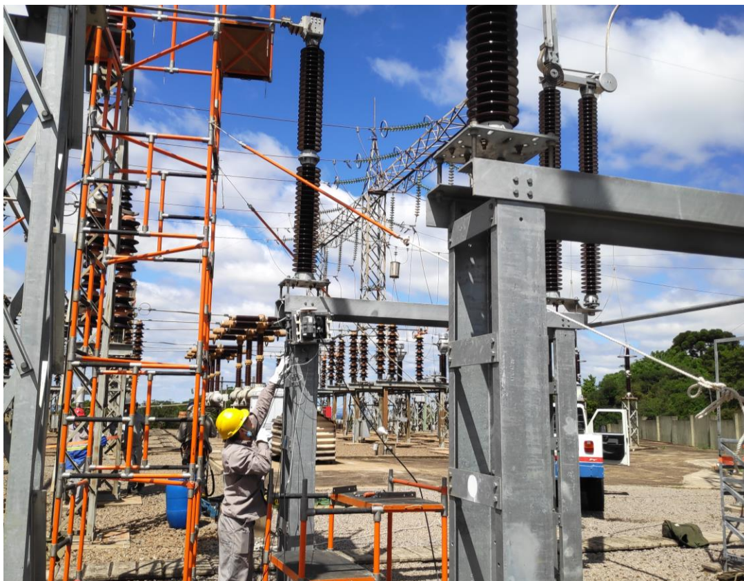
Figura 54 - Instalação do motovibrador linear na chave seccionadora da subestação da Santa Marta
