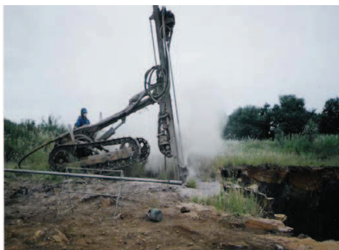
Figura 29 - Perfuração de pedreira usando perfuratriz Wagon-Drill.
