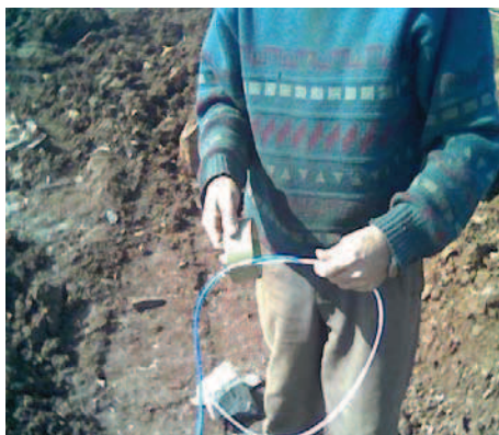
Figura 38 - Conjunto espoletado fixado a rede de cordel NP-10
