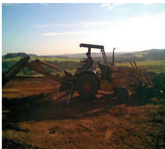
Figura 27 - Capeamento mecânico da pedreira
