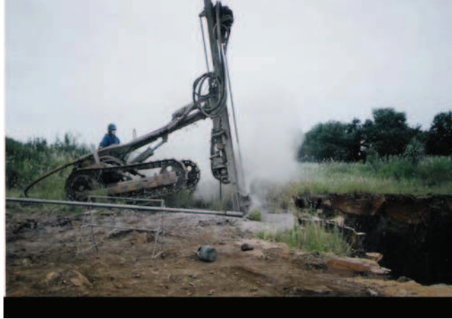
Figura 4 - Método Perfuração Linear
