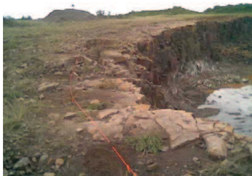
Figura 37 - Furos carregados e rede amarrada com cordel detonante NP-10.
