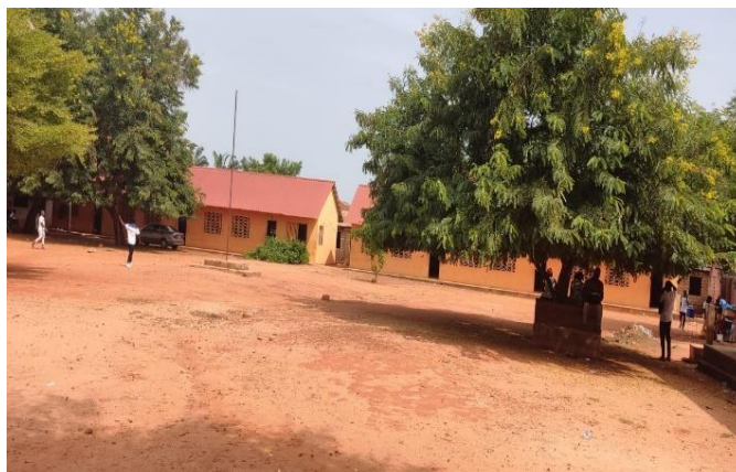
Figura 3 - Vista lateral dos pavilhões da escola
