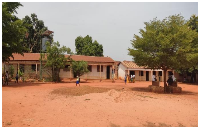
Figura 4 - Vista frontal dos pavilhões da escola
