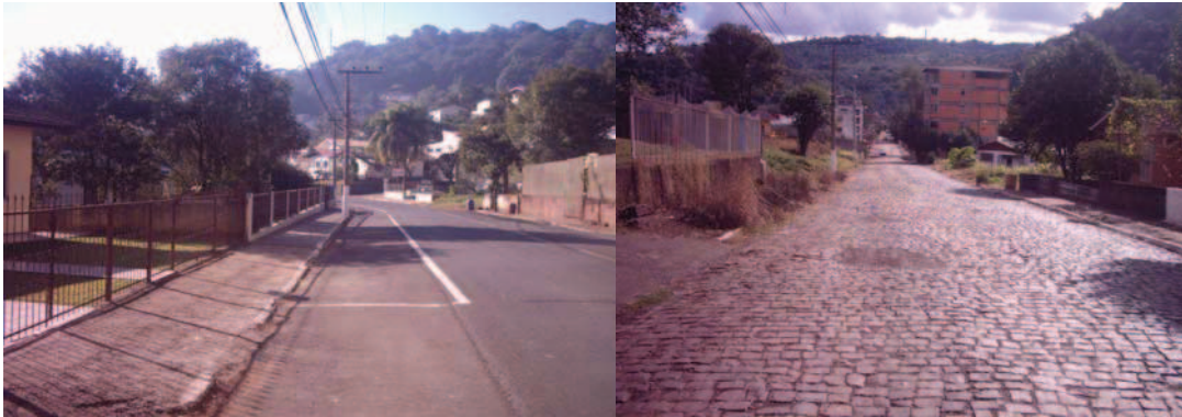
Figura 23 - Pavimentação da Rua Antônio Nunes - asfáltica e pavimentação Rua Achilles Pedrini – paralelepípedos regulares. Fonte: Arquivo Pessoal, 2006.
