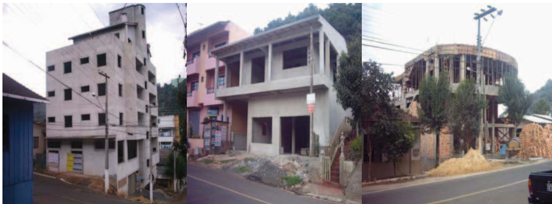
Figura 45 - Edificações em construção com destinação de uso misto. Arquivo pessoal, 2006.
