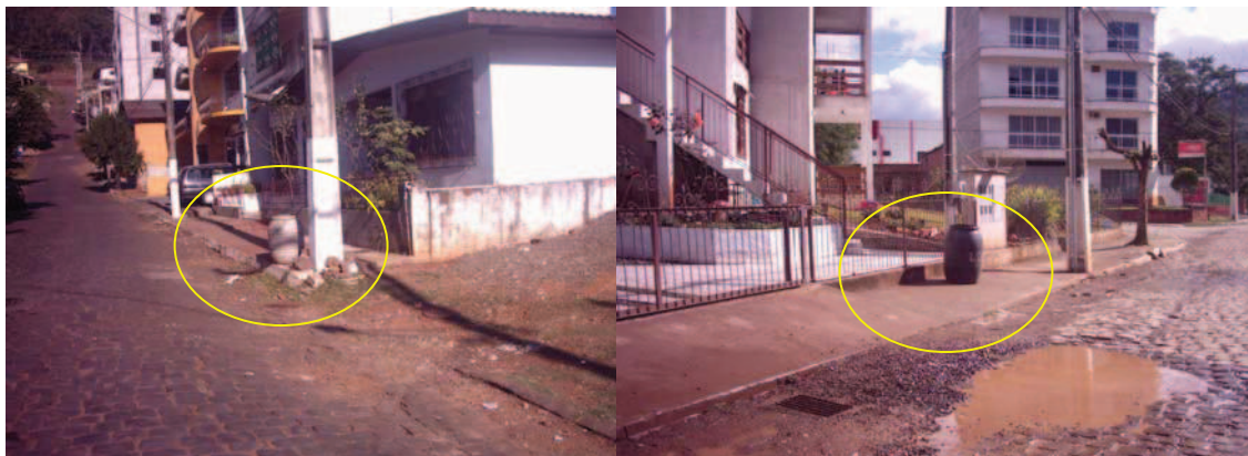
Figura 39 - Armazenamento dos resíduos sólidos a espera da coleta - comprometimento da drenagem pluvial devido o estado lastimável da pavimentação viária.
