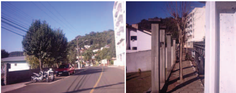
Figura 33 - Arborização em trechos da Rua Antônio Nunes Varela – causa de problemas. Fonte - Arquivo pessoal, 2006.
