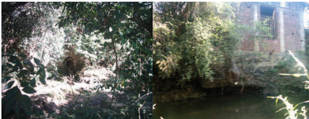
Figura 49 - Deságüe da tubulação pluvial e edificação antiga construída dentro do leito do Rio do Tigre, inclusive com uma parte de sua base suspensa em virtude da ação das águas.
