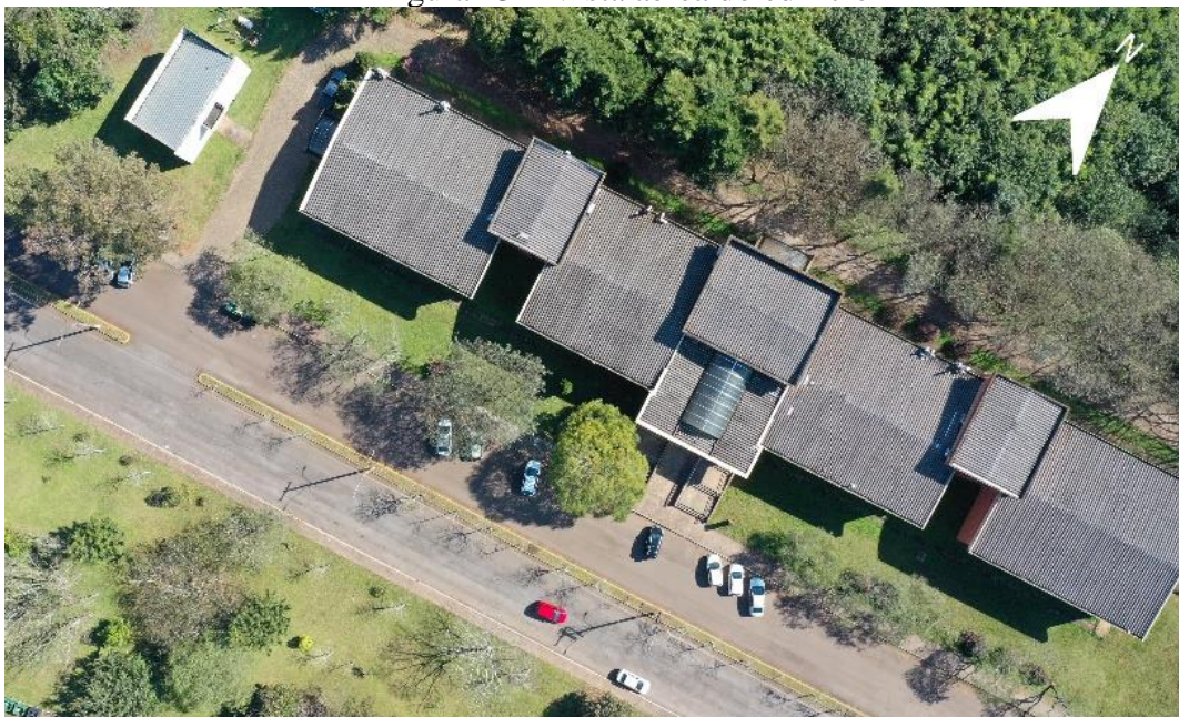
Figura 23 – Vista aérea do edifício L1
