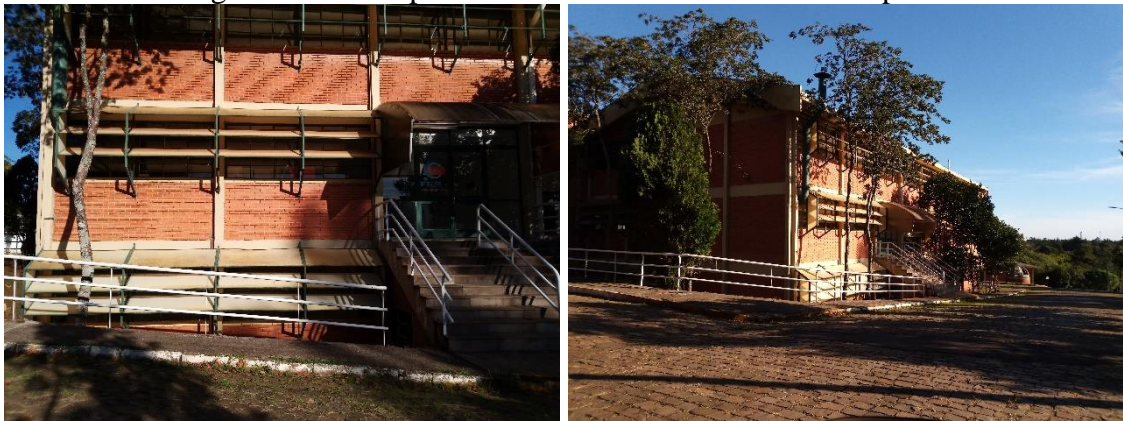
Figura 53 - Exemplo de brises-soleil utilizado no Campus I
