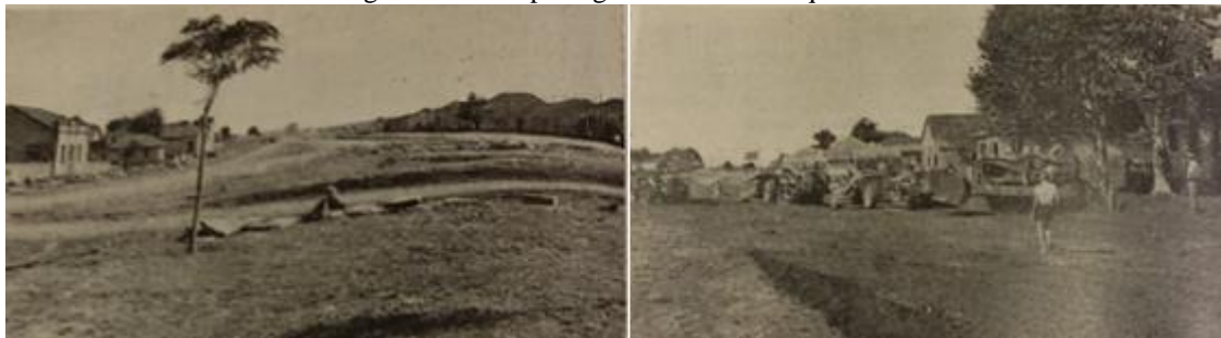
Figura 12: Terraplenagem no Bairro Boqueirão
