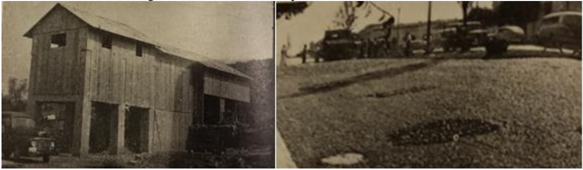
Figura 11: Britadeira Municipal e Asfaltamento Gal. Neto
